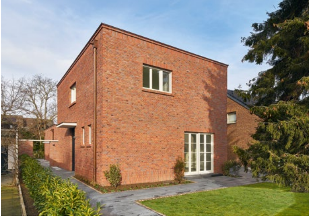
Die im Kreuzverband gemauerte Backsteinschale ist von handwerklichen Details geprägt.
