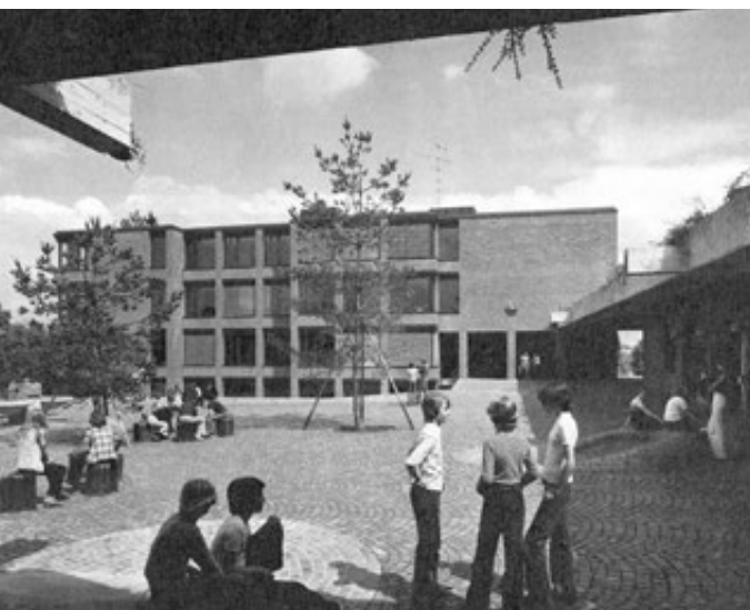
Der ursprüngliche Charakter der Schulanlage aus den 1970er-Jahren blieb bei der Erweiterung erhalten.
