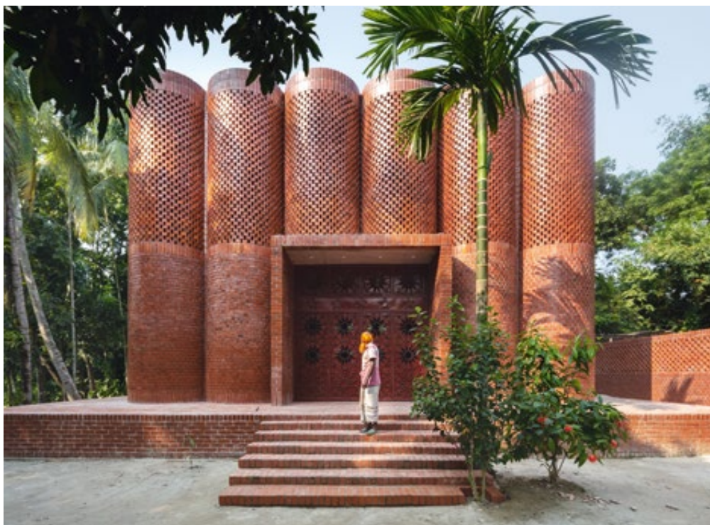
Das Jali-Gitter, das vom Mauerwerk im oberen Bereich des Mausoleums gebildet wird, sorgt für eine natürliche Luftzirkulation.
