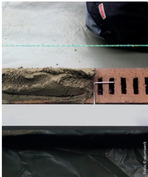
▲ Besonderes Augenmerk liegt auf der Mörtelüberdeckung des Drahtankers und seiner mittigen Lage in der kurzen Lagerfuge.
