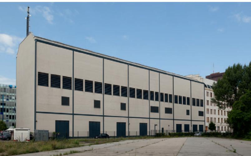
Im Sinne von Beständigkeit wählten wir hellbeigen, glasierten Backstein als Fassadenmaterial, an den Übergängen zu den Metallteilen als Formteil ausgebildet. Die Farbgebung der Metallprofile ist für das Kältewerk Dunkelblau, als Symbol für Wasser gleich Kälte.
