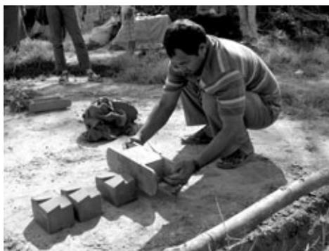
▲ Die Form wird kopfüber auf den Boden geschlagen und der Ziegel vorsichtig aus der Form gelöst.
