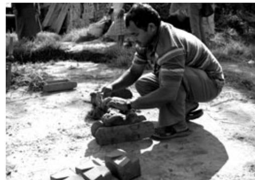
▲ Zum Verdichten des Lehms schlägt er die Form auf dem Boden auf. Mithilfe eines Halmes zieht er den überschüssigen Lehm ab.
