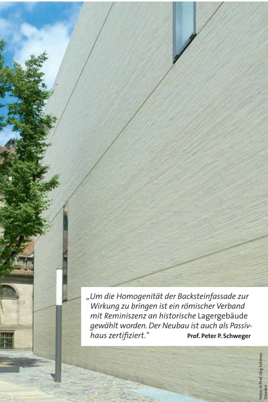
„Um die Homogenität der Backsteinfassade zur Wirkung zu bringen ist ein römischer Verband mit Reminiszenz an historische Lagergebäude gewählt worden. Der Neubau ist auch als Passivhaus zertifiziert.“
