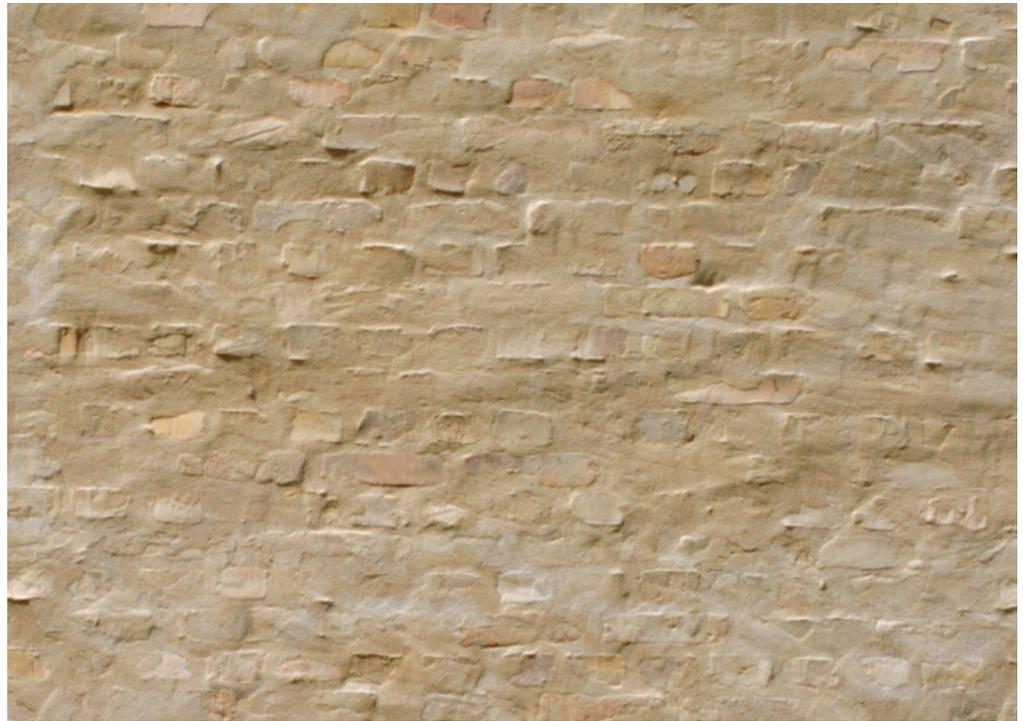
▲ Die Fassade der Galerie Am Kupfergraben entstand aus hellen Ziegelsteinen, die bei abgebrochenen Altbauten geborgen wurden. Anschließend wurden die Ziegel mit einer dünnen kalkfarbenen Mörtelschlemme überzogen.
