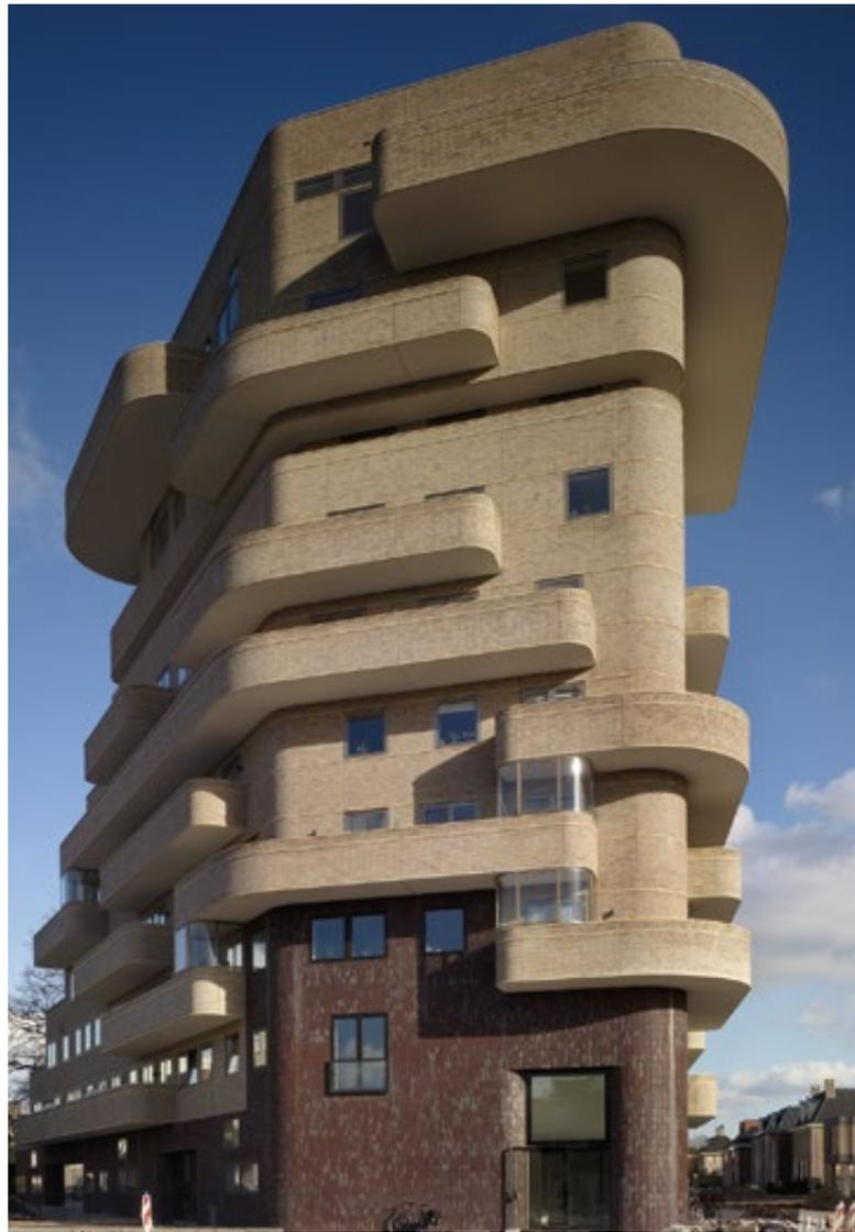
◀ Die beiden obersten Balkone wurden vor Ort gegossen. Der auf das Zentrum des Viertels ausgerichtete Balkon ist bis zu drei Meter tief.
